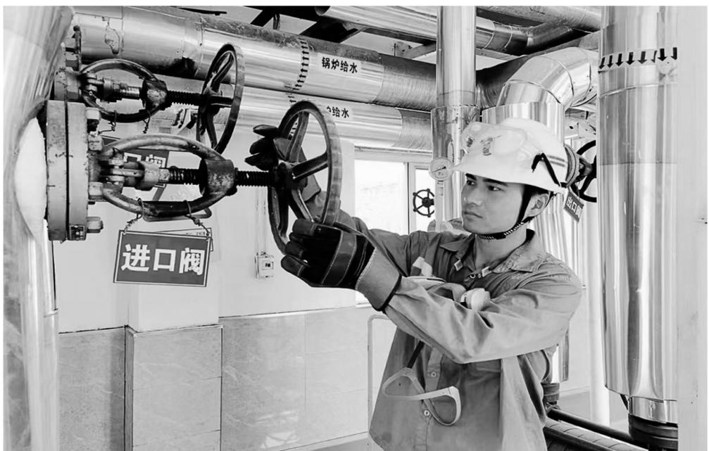
图为章健在调节低温余热回收系统锅炉给水泵进口阀。
