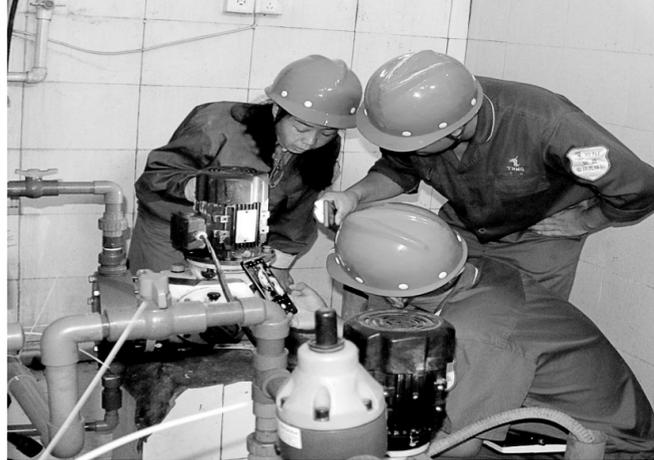
近日,为做好供水生产,进一步提升水质,动力厂结合“党员安环先锋队”活动,加强供水车间的生产技术工艺交流。来自两个供水车间的先锋队队员围绕澄清、加药、制泥、排泥等制水主要工艺环节,交流设备运行情况,保障安全优质供水。图为先锋队队员在查看加药泵运行情况。董玲摄
