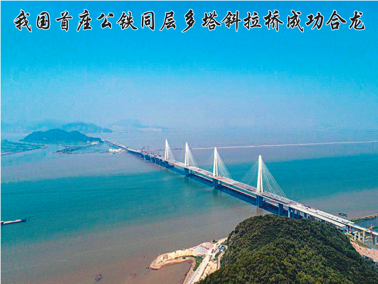
9月5日,由铁四院设计、中铁大桥局施工的我国首座公铁同层多塔斜拉桥——珠机城际金海特大桥成功合龙。金海特大桥起自珠海横琴新区,跨越西江磨刀门水道,终至珠海机场东路,是珠机城际二期关键控制性工程。大桥全长1369米,宽49.6米,中间为时速160公里的双线城际铁路,两侧为时速100公里的双向六车道高速公路。
