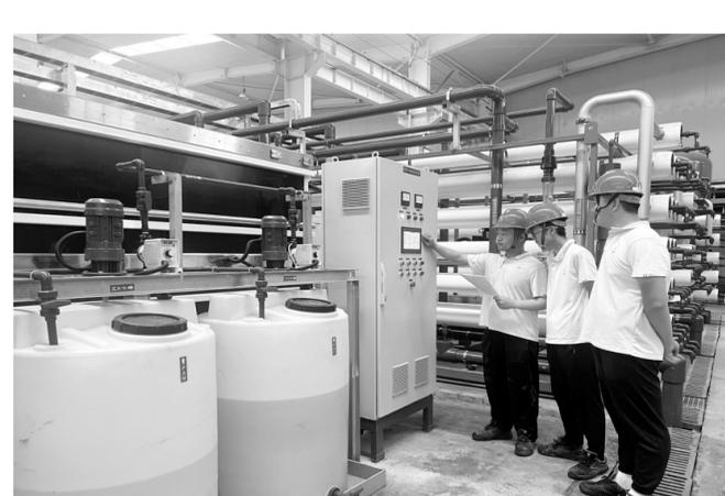
日前,铜陵铜箔公司引进一台CME电化学设备,该装置能够同利用电化学反应去除水中的重金属,实现氧化反应固液分离,有效增强了对污水中重金属的捕捉能力。图为该公司水处理人员正在进行CME设备操作培训。刘洋摄
