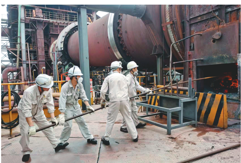
为稳定生产,确保窑头正常下球,近日,铜冠冶化分公司球团车间员工克服窑头70摄氏度的高温,对窑头隔筛大块进行处理。图为处理现场。 卞爱华 摄
