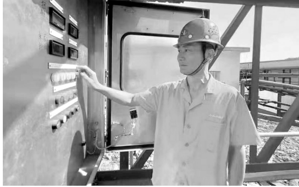
图为邢电光在检查高效浓密机的运行状况。
