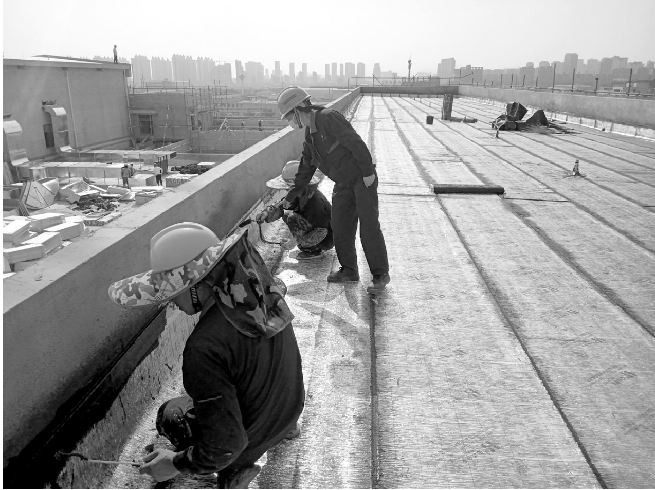
图片为江爱香(中)在对铜箔二期熔铜屋面卷材施工的卷材封边工序进行指导和检查。
