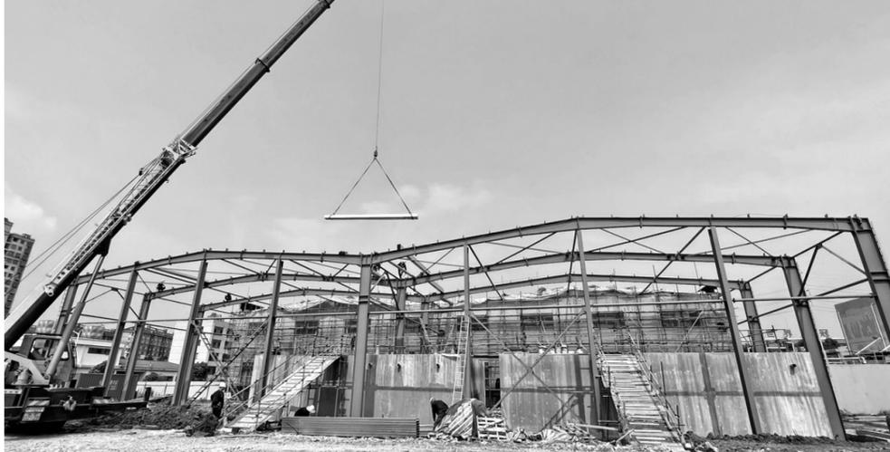
近日,铜陵铜箔公司施工方正在吊装水处理厂房钢结构框架。该公司为保障年产2万吨高精度储能超薄电子铜箔项目(二期)污水处理能力同步跟上,加快水处理二期项目建设进度,努力实现按期投入使用。
