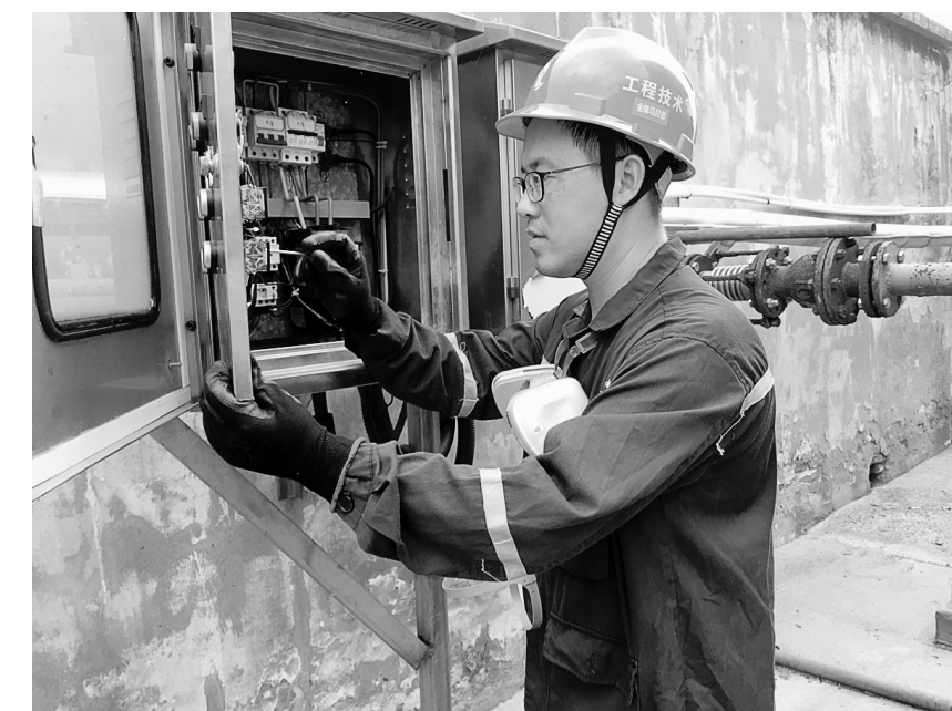
曹凯在金隆铜业公司稀贵深综合区域更换控制箱按钮。
