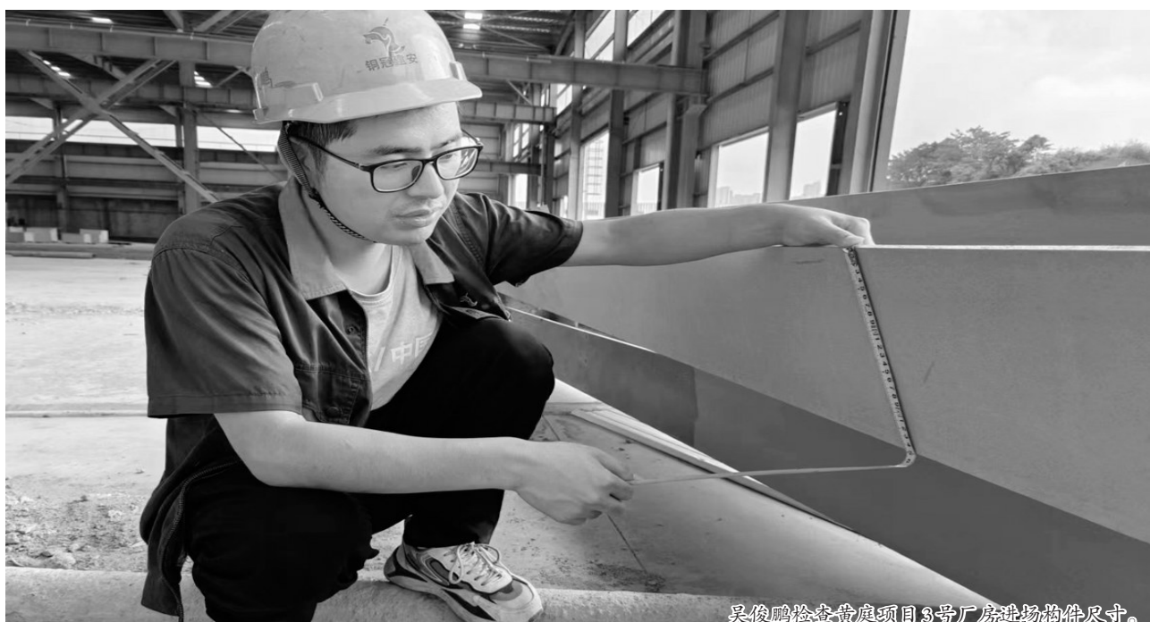
吴俊鹏检查黄庭项目3号厂房进场构件尺寸。
