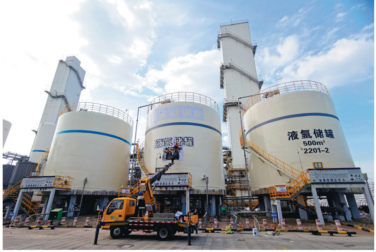
工程技术分公司2021年党委党建攻关项目“治化企业现场防腐机械化应用研究”目前已在集团公司各治化单位内广泛推广应用,实现了现场防腐工程的绿色自动化作业,作业效率大幅提升。图为近日该公司在金冠铜业设备大修中运用智能化水射流机器人首次对液氧、液氮储罐进行除锈、防腐和自动化涂装作业,仅用18天就完成了3台罐子的防腐施工任务。王素华 摄
