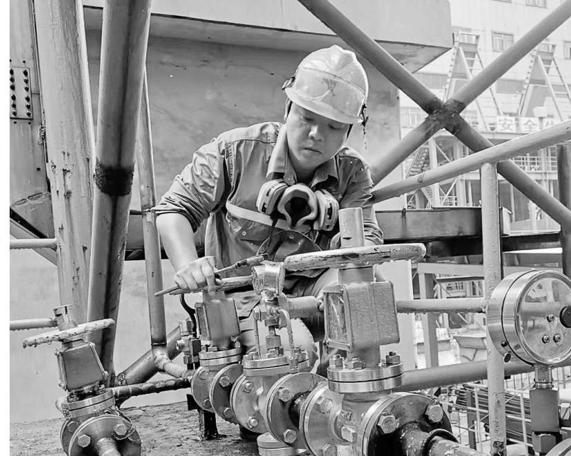
干剑在巡检维保低压蒸汽阀门。
