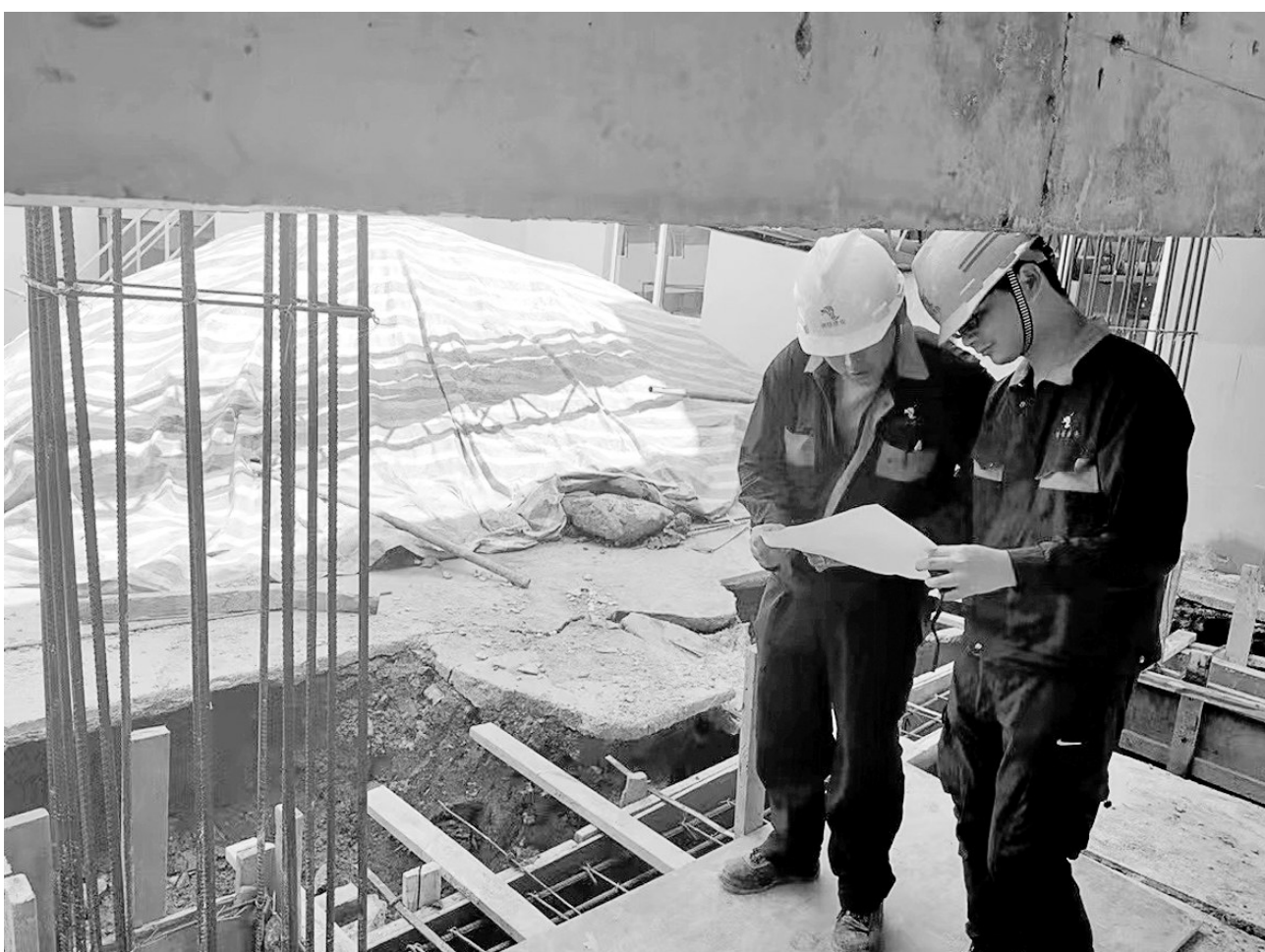
程鑫(前一)在金冠协力5号除尘器项目现场与工长沟通框架柱预埋件问题。
