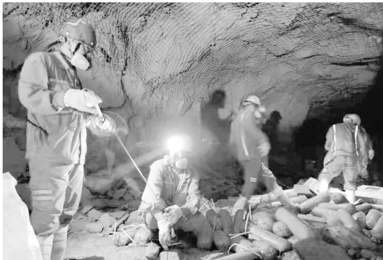
陈剑南(左一)在井下大孔装药现场进行装药工作。
