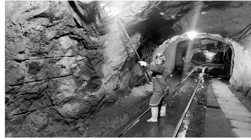
日前,安庆铜矿机运工区为进一步加强井下顶板安全管理,组织人员对爆破作业影响区域的顶板板进行巡查排险,通过强化作业人员日常检查、专业人员巡检和工区专项检查,持续做好找顶问帮工作。图为员工对负580米2号西沿线的顶板板进行巡检排查。 张 华 汤海斌 摄
