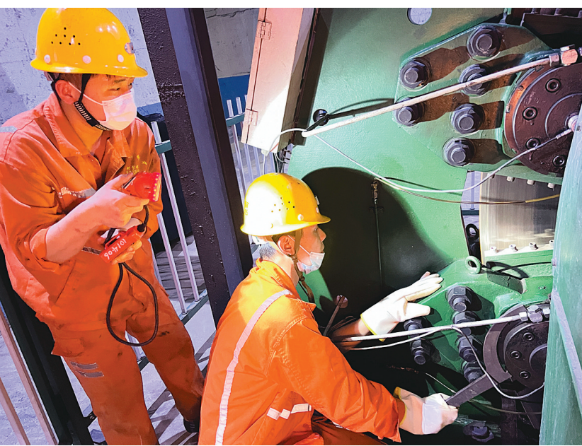
日前,冬瓜山铜矿提升二区维修人员在盲混合井负730中段对卷扬设备进行点检。该矿持续开展好“设备见本色”活动,建立长效机制,强化设备现场精细化管理,狠抓关键设备的巡检和维护,确保关键设备稳定运行,为矿山安全高效生产提供有力的设备保障。 汤菁 夏翔 摄
