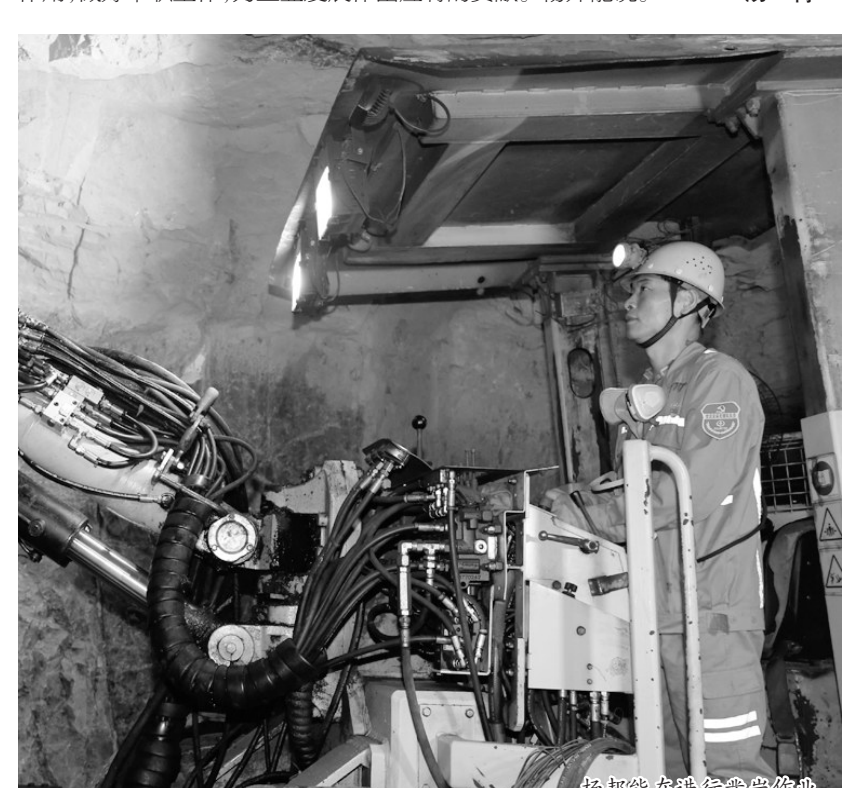
杨邦能正在进行凿岩作业。
