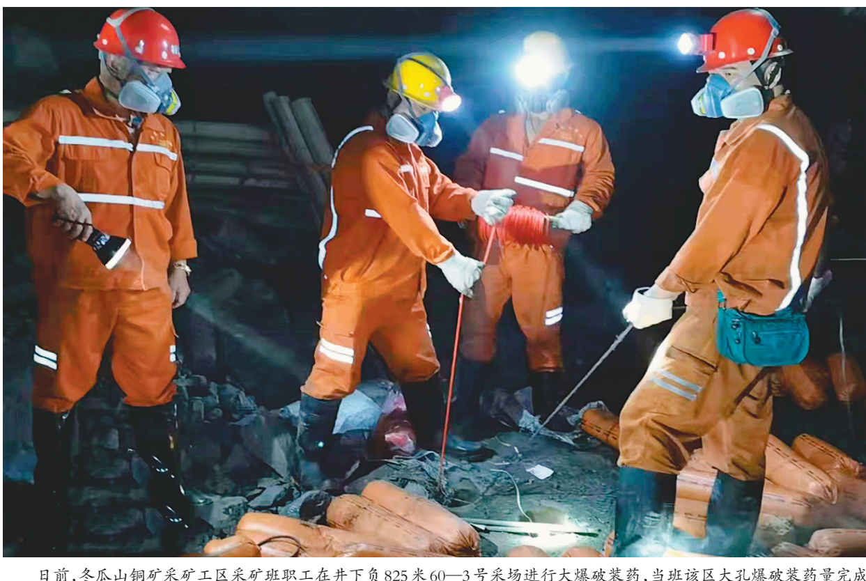
日前,冬瓜山铜矿采区采矿班职工在井下负825米60—3号采场进行大爆破装药,当班该区大孔爆破装药量完成3600千克。连日来,该矿一手抓疫情防控,一手抓好各项生产管理工作,全矿1800余名职工有序进入到各个工作岗位,全力以赴多干多超,努力实现全年生产目标。 汤菁 陈勇 摄
