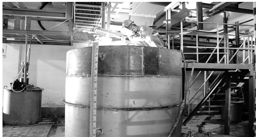
为保证新产品性能稳定性,今年以来,铜冠铜箔公司不断加强设备改造,先后对表面处理和配液工序进行改造。图为该公司对配液工序槽罐进行扩容改造。 何亮王琦 摄
