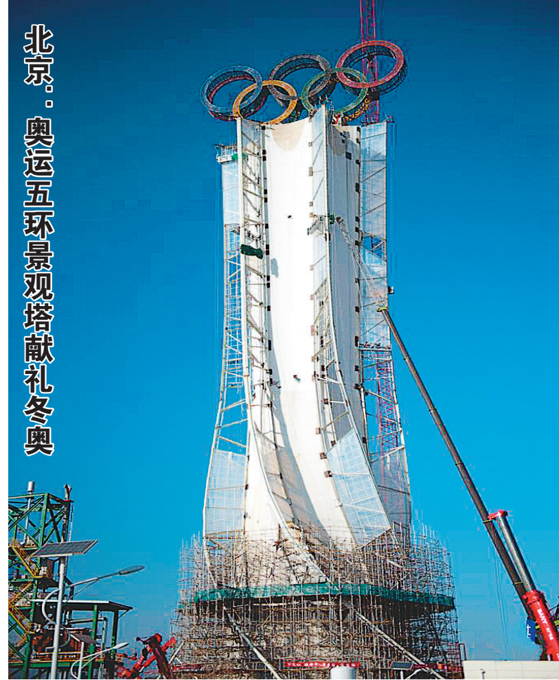
这是1月11日拍摄的“海陀塔”。近日,位于北京冬奥会延庆赛区的“海陀塔”上的奥运五环结构吊装作业完成,进入工程收尾阶段。塔顶设置奥运五环标志,表面安装了共计7万余个白色点光源,塔身加装飘带形装饰。据介绍,“海陀塔”预计2022年1月底前完工,届时将在夜间点亮灯光景观,成为北京冬奥会标志性景观之一。 新华网
