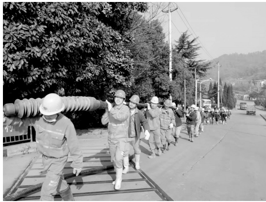
近日,冬瓜山铜矿动力车间在110千伏变电所检修中,发现GIS室110千伏母联有异常声音,立即向矿相关部门汇报。为做到防患于未然,检修期间不忘安全兜底,该车间组织70余人将3根240平方毫米的110千伏电缆从仓储中心运至110千伏变电所(如图),确保GIS室供电出现故障时,能快速恢复矿山正常供电。陶信宁 摄
