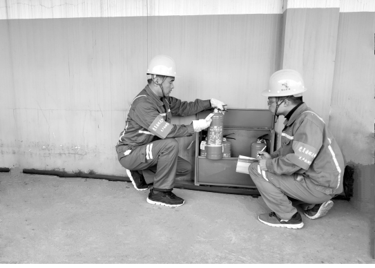
入冬气候干燥,火灾隐患增多,铜山铜矿分公司生产机动“党员安环先锋队”对消防设施、用电线路进行隐患排查,及时消除隐患,确保冬季安全。
