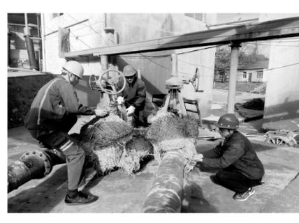
针对近期低温寒冻天气,铜山铜矿分公司本着“不冻坏一台设备,不冻堵一条管线”的目标,为设备设施量身制作“防冻衣”,让设备设施经得住寒流侵袭,保障系统设备高效运行。图为选矿车间员工为室外生产管道穿“冬衣”。张 霞 刘彬 摄
