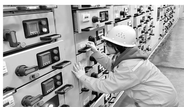
2021年12月16日,铜冠(庐江)矿业公司选矿车间对所有配电所低压柜、抽屉柜标识牌进行更换(如图)。随着5S精益管理的不断深入,该车间制作了新型透明亚克力标签牌替换之前不规范的标识和记号,并重新制作分布图,为检修提供了保障。王树辰 张 巍 摄
