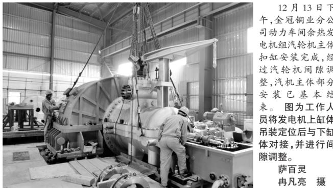
12月13日下午,金冠铜业分公司动力车间余热发电机组汽轮机主体扣缸安装完成,经过汽轮机间隙调整,汽机主体部分安装已基本结束。图为工作人员将发电机上缸体吊装定位后与下缸体对接,并进行间隙调整。
