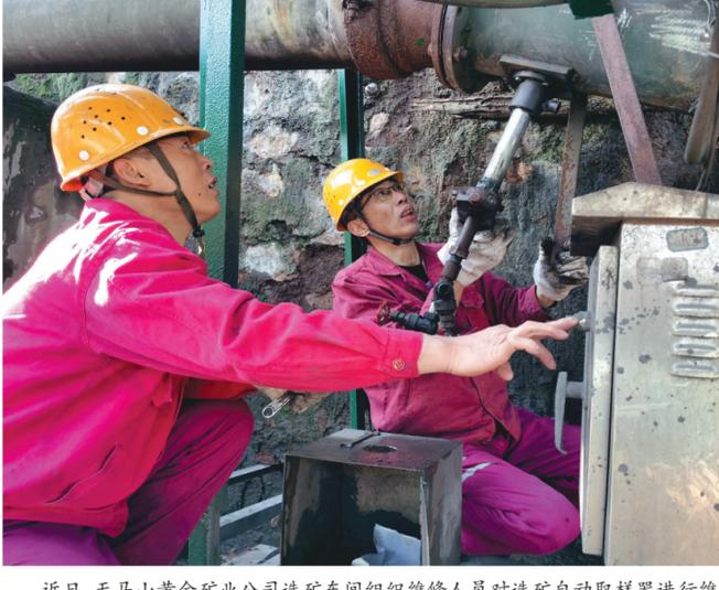
近日,天马山黄金矿业公司选矿车间组织维修人员对选矿自动取料器进行维护保养(如图),确保取料器正常工作,为稳定生产技术指标提供了有力保障。吴燕摄
