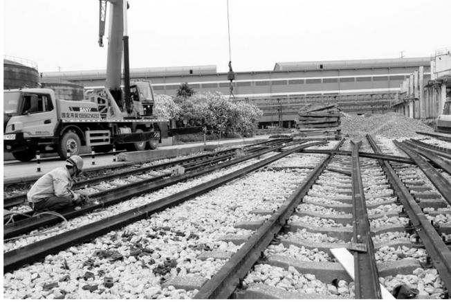
金隆铜业公司厂区内,以前用于硫酸运输的废旧铁轨正在被拆除(如图)。近年来,公司产品运输方式发生转变,建厂初期的铁路已完成了历史使命,为实现总图优化,该公司对铁轨进行拆除,并进行二次利用,变废为宝,最大限度地发挥了铁轨的利用价值。
