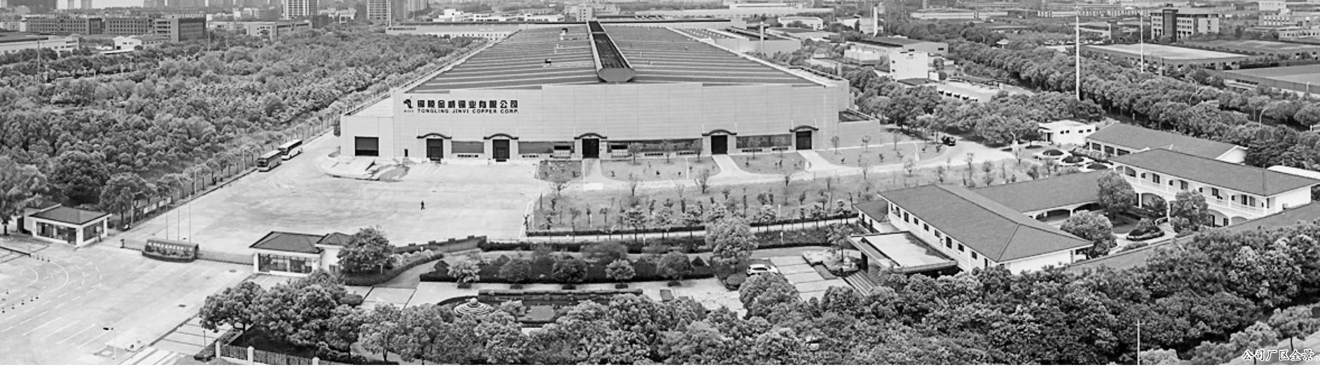
公司厂区全景。
