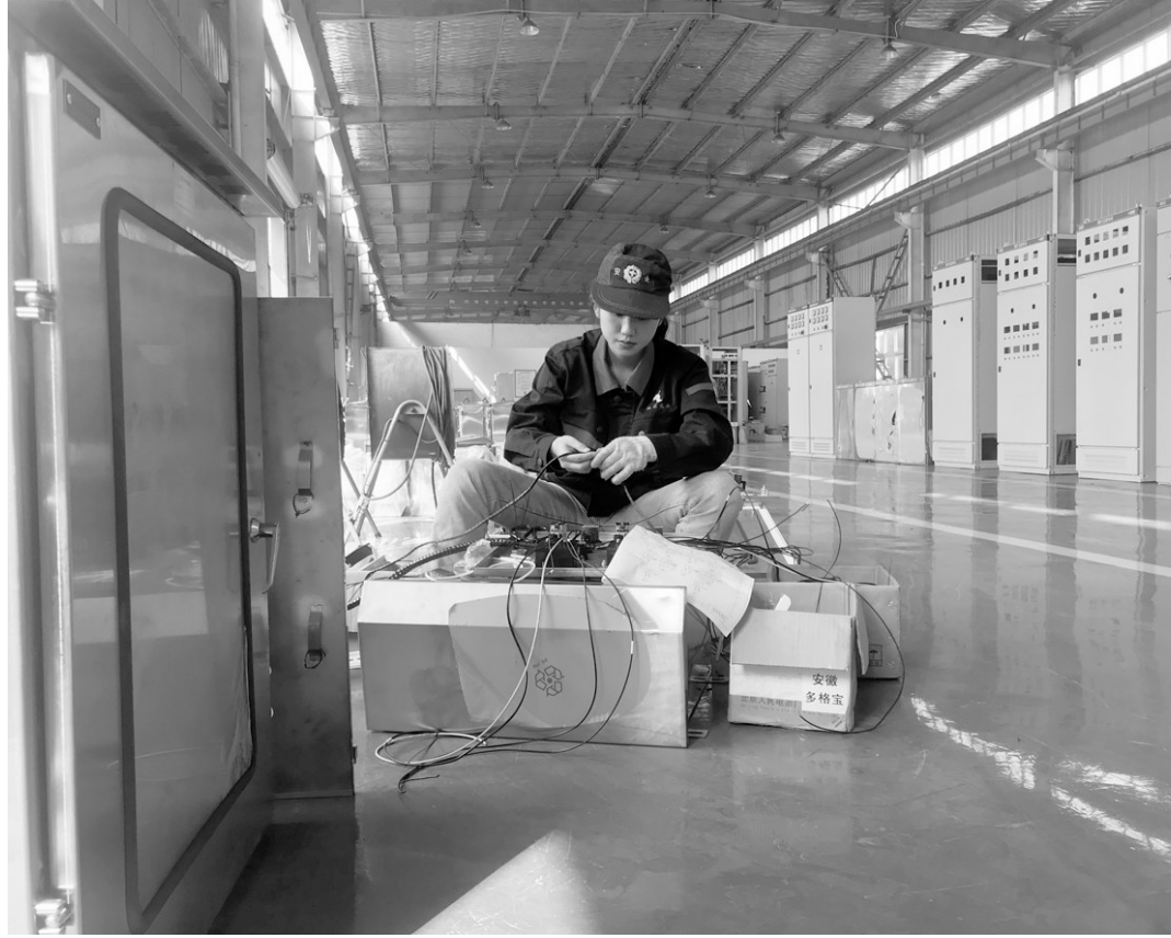
铜冠建安电控设备厂职工日前正在车间进行装配作业。该厂在保主保重,确保集团公司重点工程项目需要的同时,积极开拓外部市场,承接配电柜任务,组织职工加班加点,确保在手项目的生产工期和质量,咬定全年方针目标不放松。
