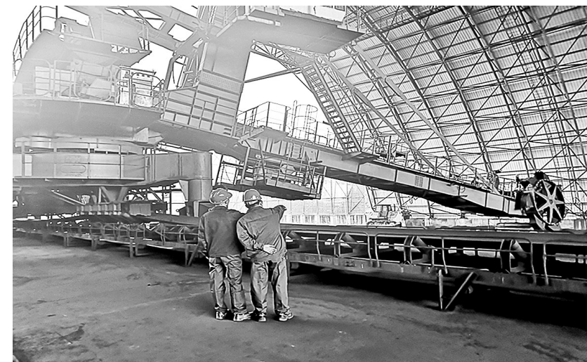
热电1号机组大修,是动力厂当前一项重点工作。近日,该厂纪委深入大修现场,对外来检修施工人员的疫情防控、锅炉钢架防腐、高空作业等现场进行了监督检查,并与相关责任领导进行了谈话交流,提醒大修期间,在做好大修各项工作的同时,要积极做好疫情防控和廉洁教育工作,并将安全管理工作贯穿大修全过程。
