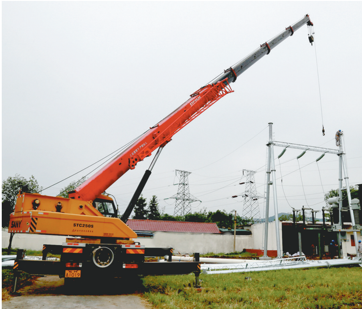
10月18日,安庆铜矿为期10天的年终检修正在火热进行中,为保障年终检修工作顺利进行,该矿参加检修的干部职工鼓足干劲、齐心协力,按照矿年终检修计划安排,全力推进、落实,确保检修工作安全、高质、高效完成。图为检修人员正在对矿动力车间454线总降龙门架进行更换。
