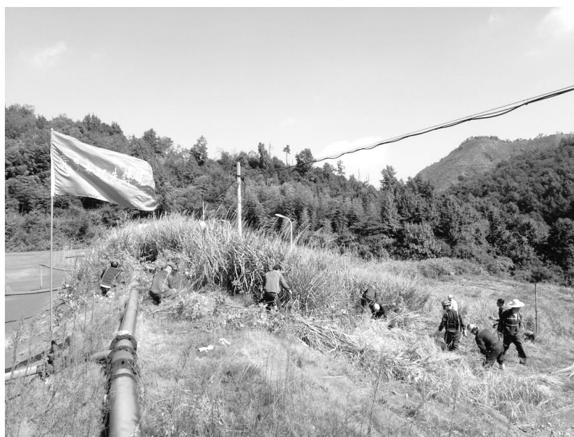
近日,铜山铜矿分公司选矿车间党员安环先锋队对副坝坝面上的杂草进行清除(如图)。为确保尾矿库安全运行,该车间组织人员对章家谷尾矿库进行专项检查,并组织安环先锋队队员对主副坝坝体上的茅草、灌木丛等进行清除。
