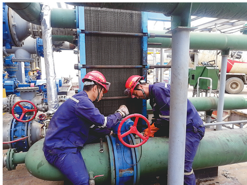
9月8日,工程技术分公司金冠项目部奥炉机械班接到业主金冠铜业分公司奥炉精铸车间发生故障需立即抢修的检修指令后,该公司现场检修人员迅速应对,凭借技术优势快速查找故障原因,高效完成抢修任务,有力保障了业主单位生产设备正常运转。图为检修人员分工协作,更换绝缘套工作场景。 刘星 摄
