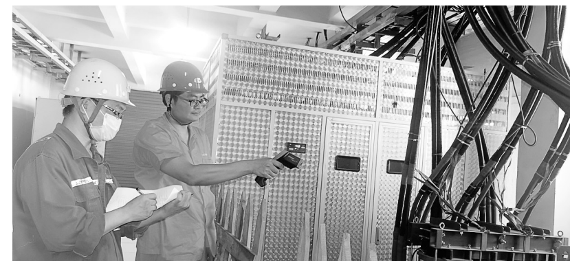
8月18日,冬瓜山铜矿提升一区职工对全区电气设备的端头、电缆、变压器及轴承部位进行测温点检(如图)。进入三季度,该区持续做好高温季节设备的点检、维护和巡查力度,将安全隐患消除在萌芽状态,在确保设备安全稳定运行的同时,也为实现安全生产提供可靠的保障。
