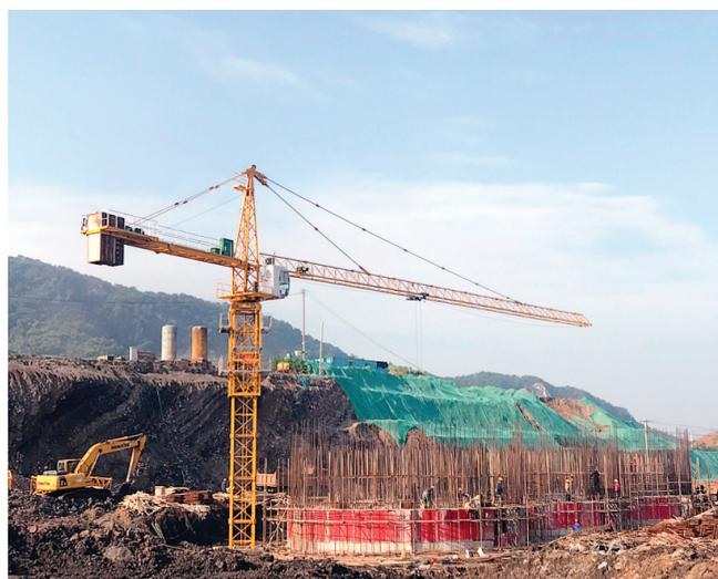
8月25日,铜冠建安公司承接的金磊矿业公司铜山矿区大凹山-寒山水泥用石灰岩矿露天开采项目紧张施工中。该项目主要有筛分车间、粗碎车间、产品库、半成品库、转运站、产品库地下廊道等内容。为了干好这项集团公司重点工程,铜冠建安公司两个专业公司全力以赴投入工程大干,加速推进工程进度,努力完成业主的目标任务。
