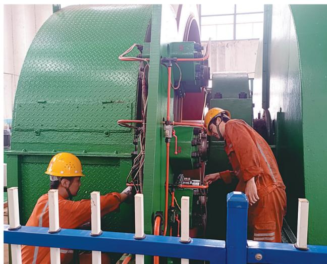
近日,冬瓜山铜矿提升二区维修人员对卷扬机盘型制动器刹车间隙进行调整。为确保卷扬机安全运行,该工区组织维修工使用专业工具对每个刹车间隙认真测量调整,使其符合标准。
