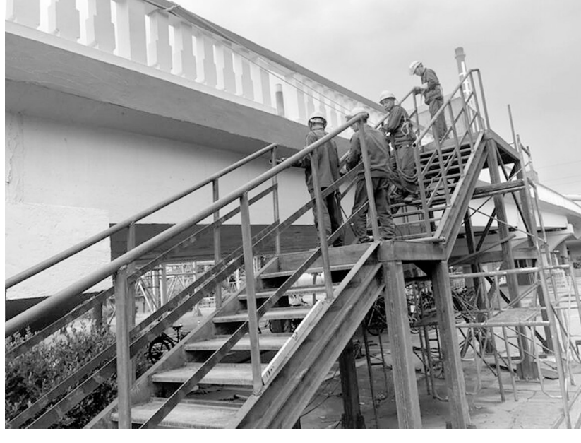
金隆铜业公司在党史学习教育中,重点着力“我为群众办实事”,想职工群众之所想,全心全意为职工办实事。近日,该公司本着方便、安全、就近原则,在厂区别立交桥旁搭建了上桥楼梯,解决了以往上桥需要转圈绕路的不便,收到职工群众的欢迎。图为工作人员正在焊接登桥扶梯。 章 庆 摄
