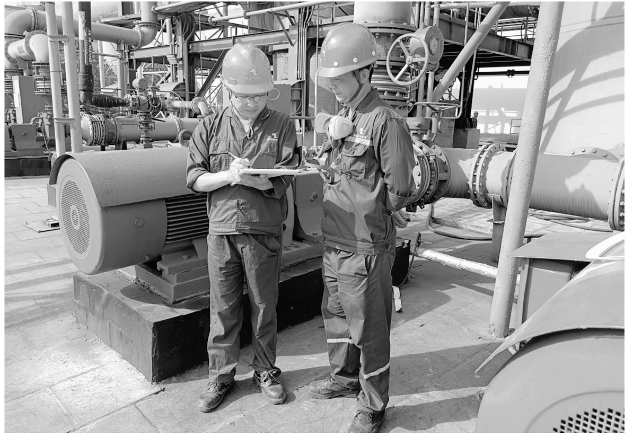
连日来,铜冠池州公司在锌分厂停产检修期间,安排安全管理人员到现场审核核批各种特殊作业证,以提高现场服务意识和特殊作业证审批效率,确保检修任务不耽擱。截至7月13日,共办理各类特殊作业证200余项。图为安全管理人员正在现场签批登高作业证。何长青 摄
