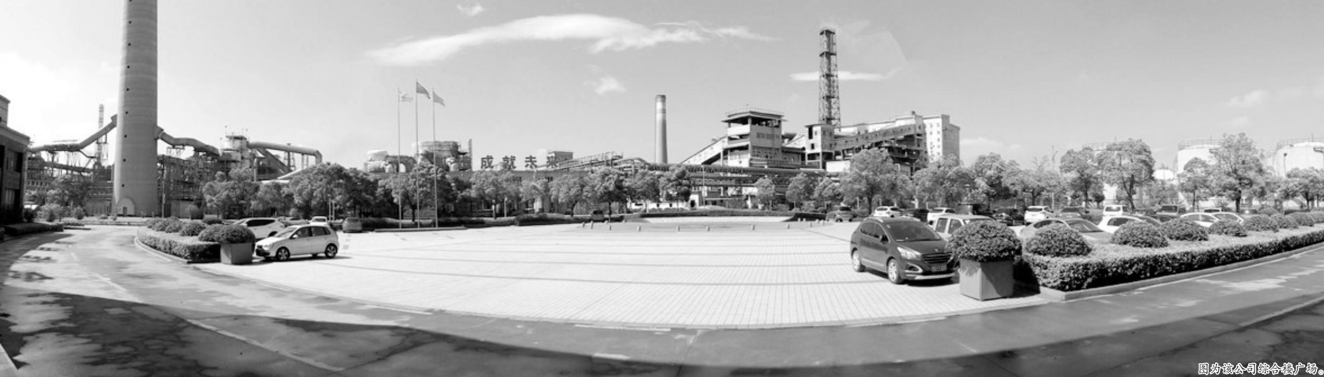
图为该公司综合楼广场。
