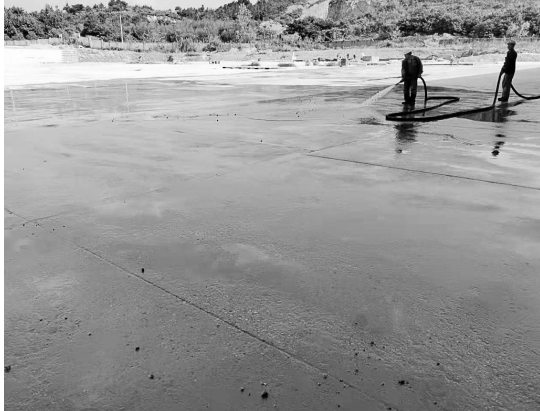
7月22日,两名职工正在对停车场进行清扫(如图)。为进一步规范矿山副产运输车辆秩序,缓解车辆调运及停放矛盾,更好地满足生产需要,日前,铜冠(庐江)矿业公司新建了一处约7300平方米的大型运输车辆停车场,现主体工程已经完工,待部分附属工程结束后将正式投入使用,届时将大大改善矿区环境,提升副产运输能力。 吴树华 汪 洋 摄
