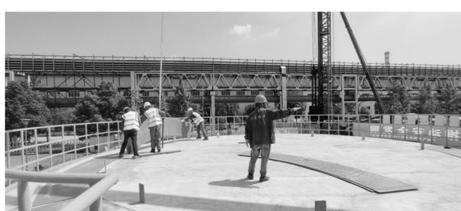
近日,金冠铜业分公司升级改造项目新增3号制氧工程中的500立方米液氮贮槽开始安装,标志着该项工程正式进入设备设施安装阶段。新增3号制氧工程500立方米液氮贮槽为液体双层低温立式圆筒形钢制焊接贮槽,是工作压力20千帕的常压容器。萨百灵 汪金春 摄
