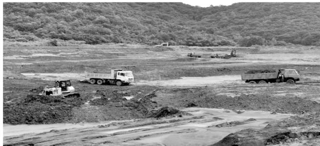
7月12日,铜冠建安公司第二建筑工程事业部承建的铜陵有色凤凰山铜矿尾砂冲尾矿库闭库治理工程正在施工。该工程总投资1421.28万元,计划工期270天,施工内容为尾砂平整、覆土植被、尾砂坝排水系统、上坝道路修整等,建成后改善库区环境,加强尾矿库闭库的安全管理。王红平 汪锡铜 摄
