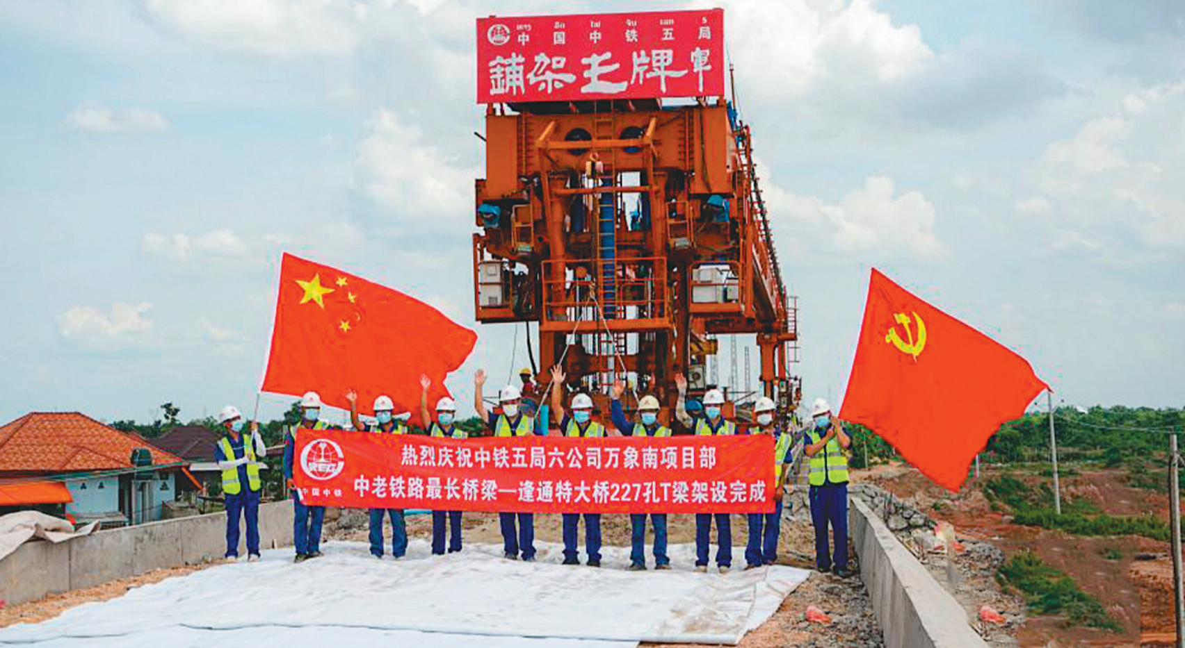
7月5日,随着架梁作业人员操作着JQT-180型架桥机将蓬通特大桥最后一块T梁落在桥台上,由中铁五局六公司承建的中老铁路最长桥梁——蓬通特大桥架设完成,标志着“一带一路”标志性工程中老铁路正线架梁贯通。蓬通特大桥位于老挝首都万象市,桥长7528.56米,共计227跨桥梁,桥梁运输、架设安全管理难度大,是本桥段的控制工程。 中新社
