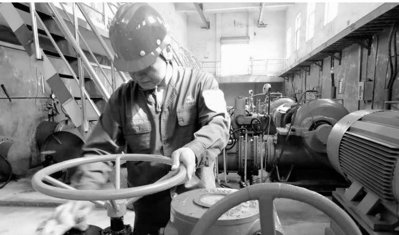
为全力整治班组现场环境,有色动力厂针对“金隆净化站”的设备设施陈旧零乱、5S不达标等问题,进一步分解责任区,做到人人肩上有指标。图为该厂“金隆净化站”班长张先顺,每天坚持在生产泵房进行设备日常维护保养。进入5月份以来,这个班组生产现场整治工作已经取得明显成效。 罗 鹏 摄
