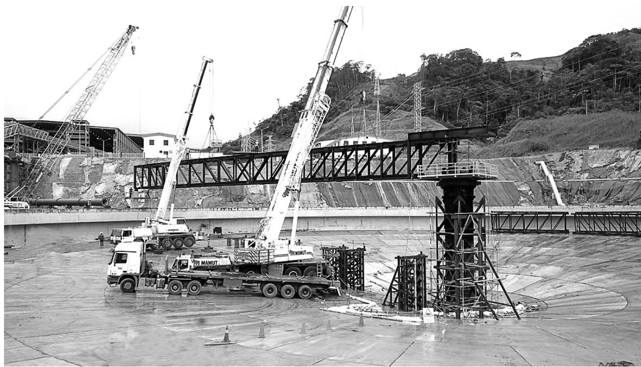
公司在海外的厄瓜多尔分公司安装直径100米的浓密机。
