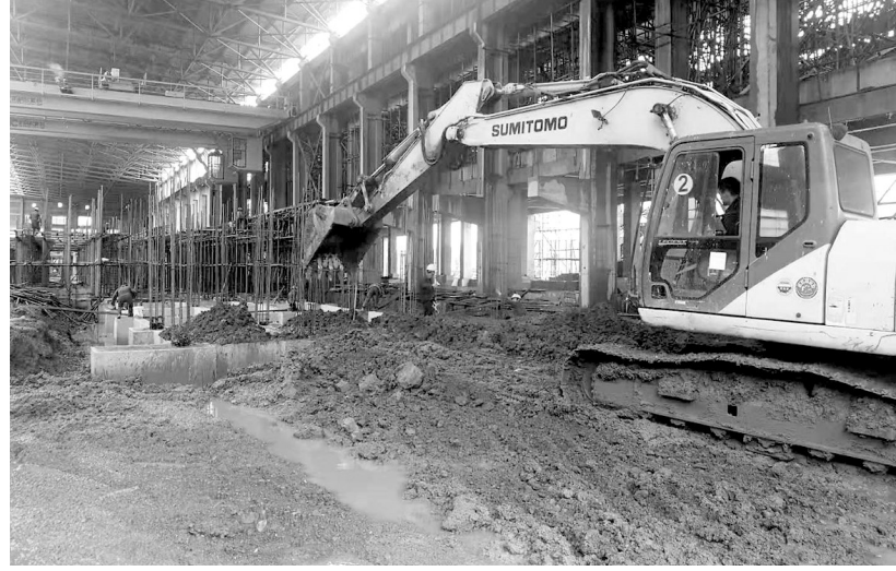
5月20日，铜冠建安公司承建的江西汇盈电解项目正加紧车间地面施工。进入五月份，连续雨天给施工工期带来了压力，该公司项目部统筹协调安排，不断调整计划，开展劳动竞赛，土建、安装、钢构、防腐等专业依据各自施工计划，发挥各自优势，展开施工大干，推进工期。王红平 汪锡刚 摄
