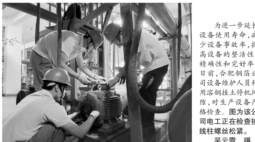
为进一步延长设备使用寿命，减少设备事故率，提高设备的整洁性、精确性和完好率，日前，合肥铜箔公司设备维护人员利用溶铜挂土停机间隙，对生产设备严格检查。图为该公司电工正在检查接线柱螺丝松紧。吴云霞 摄
