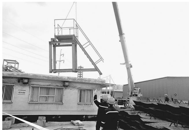
金隆铜业公司正在对精炼区域的老地磅房进行拆除(如图),将原有地块规划为原材料堆场。该公司根据厂区功能区的不断变化,动态调整各区域的不同使用功能,使之更加科学合理与实用,最大限度地提高厂区各场地的利用率。
