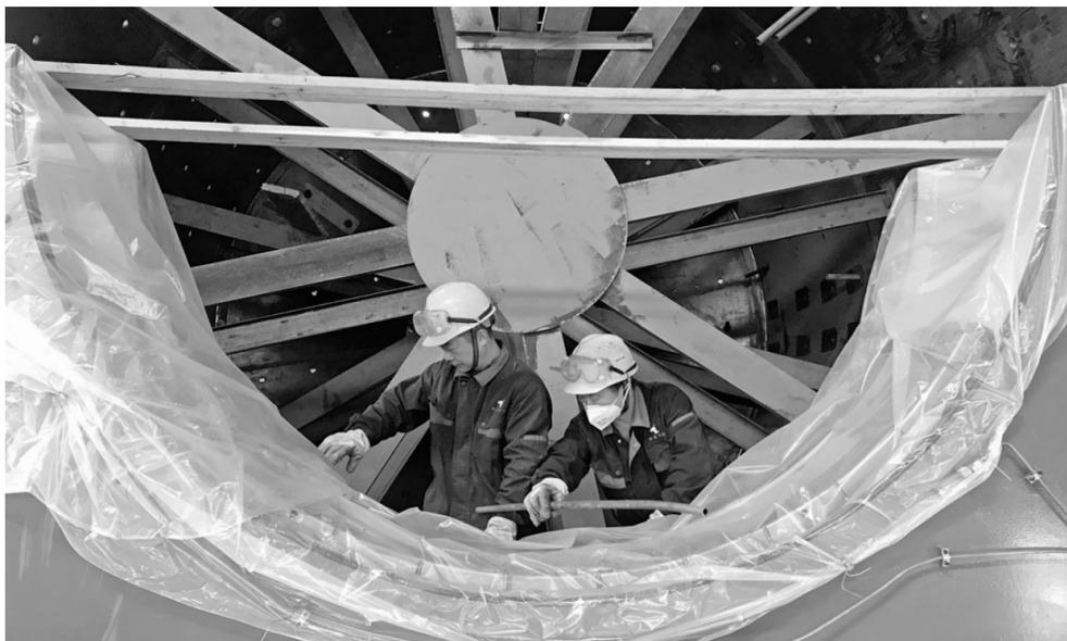
铜冠建安公司职工正在安装磨浮车间的半自动磨设备(如图)。近日,该公司承建的金隆铜业分公司渣选项目设备安装已进入攻坚阶段,安装人员在施工现场研究图纸,分解工作任务,按照计划节点积极推进工期。
