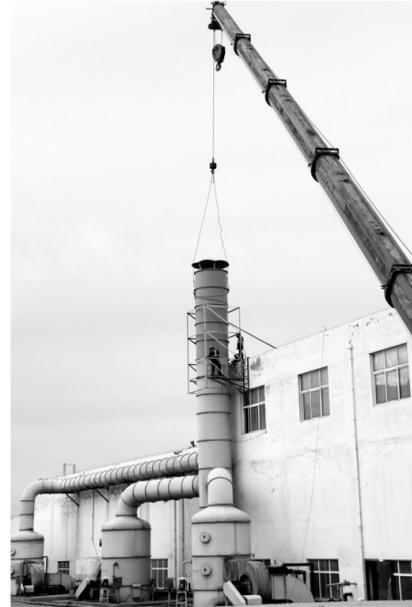
日前,为了满足最新环保需求,铜冠铜箔公司对酸雾塔进行整体改造。此次改造主要将酸雾塔排气口升高至离屋顶5米,以达到排放要求。图为现场施工人员正在对酸雾塔主体进行改造。 何亮 吴猛 摄
