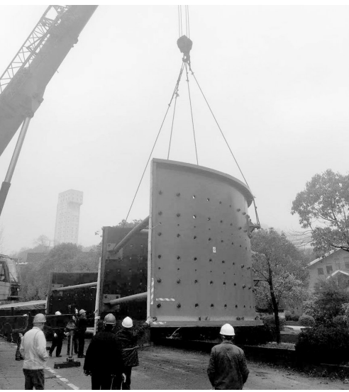
3月18日上午,铜冠建安安装公司督导人员正在项目现场进行吊装作业专项督导。连日来,该公司进一步强化了对吊装作业的安全监管,除在重点作业现场开展专项督导外,还要求各项目针对吊装作业制定专项方案,全力保障各项吊装作业安全。
