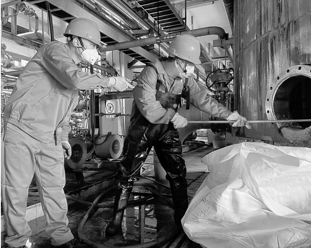
日前,铜陵铜箔公司溶铜车间员工利用停机检修,对溶铜罐进行清理铜渣作业。今年以来,锂电箔订单供不应求,该公司合理安排停机检修计划,严格执行设备巡检及保养管理制度,确保设备处于良好的状态,为完成生产任务赢得了宝贵时间。
