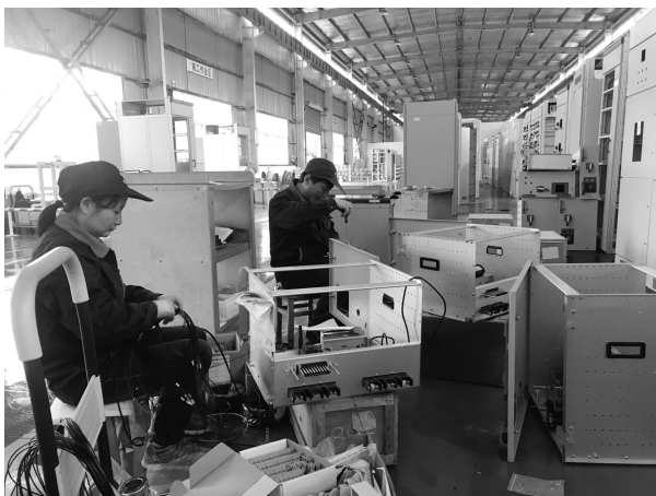
铜冠建安电控设备厂职工日前正在进行开关柜的组装修作业。今年以来,该厂针对承接的重点工程项目,严格把控节点,采取并岗交叉作业、劳赛激励等手段,千方百计确保在手项目的生产进度。
