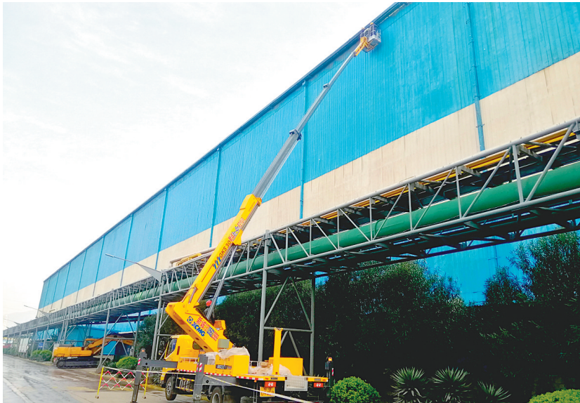
金隆铜业公司始终秉持“清洁生产,绿色生态”环保理念,将环境治理提升行动各项措施落到实处。近日,该公司加大烟气排放管控力度,对主厂房外壁、房顶等部位进行密封作业,堵塞任何可能导致烟气外溢的空隙,确保安全稳定生产。图为施工单位正利用高空作业车对冶炼主厂房漏点进行封堵。 章庆 刘胜 摄
