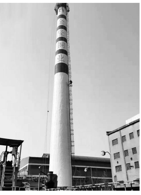
铜冠建安第一建筑工程事业部员工日前正在进行烟函美化施工。该事业部近期承接了金隆铜业公司水塔和烟函的美化、亮化工程，并针对高空作业，制定出重点、难点施工技术措施，做好安全施工技术交底，加强施工过程安全监管，较好地保证了施工进度。 王红平 陈卫娟 摄
