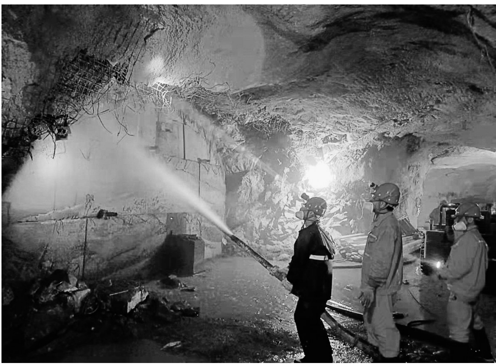
凤凰山矿业公司(庐江)充填项目部为确保采场充填衔接,对浙江其峰项目部3月1日交付的负770米中段T303采空区进行连班加点点流灰封闭作业,于11日中班全部圆满结束采场7个封闭墙支模等工序,流灰量约150立方米。同时将该采场上部中段近300米的临时充填管道全部架设完毕。 何 娇 俞忠阳 摄
