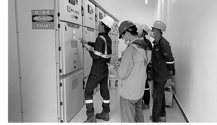
3月7日,铜冠建安厄瓜多尔分公司承建的废石胶带输送机工程1号配电室一次受电成功。其中6台高压柜及4台变压器等全部调试完成,为下一步1号、2号皮带试车打下良好基础。王红平 汪锡铜 摄
