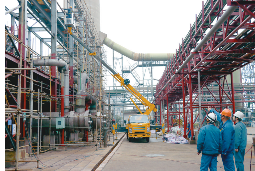
为消除隐患,美化厂区,铜冠冶化分公司开展厂区钢构安全专项整改项目,分区分片对厂区钢构进行重新防腐。为保证项目进度,落实项目负责人和现场施工安装安全及5S监督员,做到网格化管理,确保4月底厂区钢构全部换“新装”(图为施工人员在硫酸区域给钢构除锈)。卜爱华 摄
