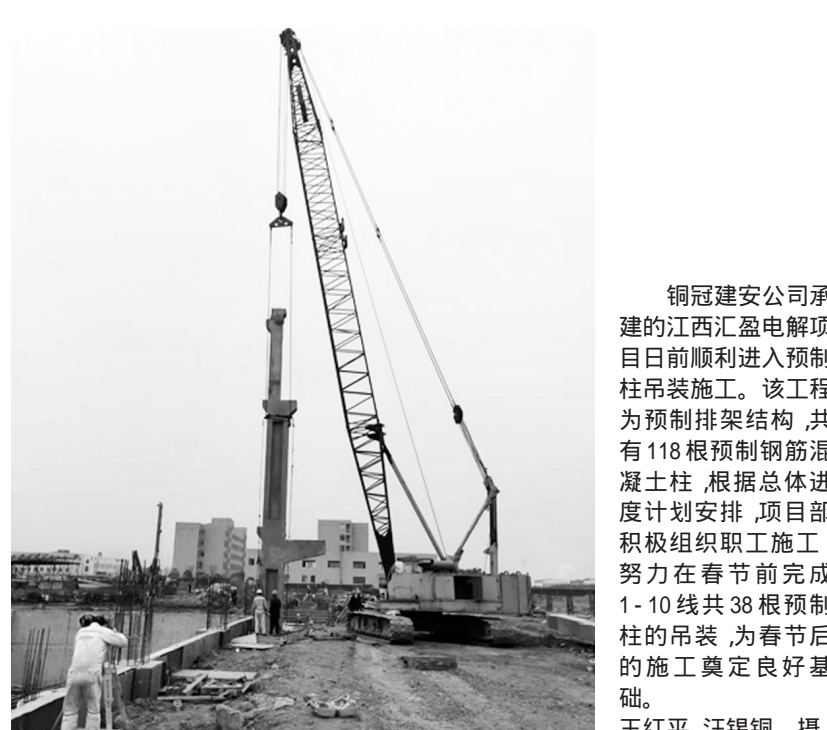
铜冠建安公司承建的江西汇盈电解项目日前顺利进入预制柱吊装施工。该工程为预制排架结构,共有118根预制钢筋混凝土柱,根据总体施工进度计划安排,项目部积极组织职工施工,努力在春节前完成1-10线共38根预制柱的吊装,为春节后的施工奠定良好基础。 王红平 汪锡铜 摄
