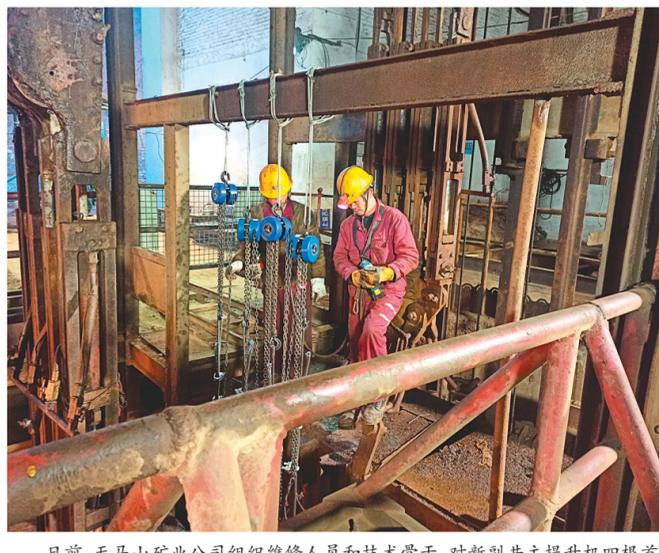
日前,天马山矿业公司组织维修人员和技术骨干,对新副井主提升机四根首绳进行了更换。经过三天的加班加点,技术人员按照方案,在确保安全的前提下顺利完成更换任务,为公司的安全生产奠定了基础。
